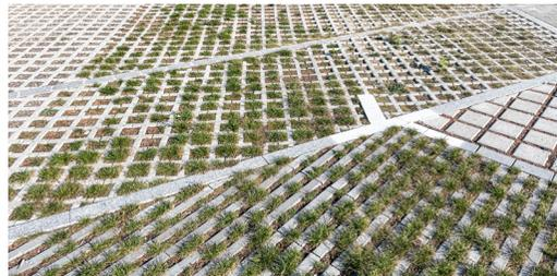
Abb. 9: Schnitt durchlässiger Belag Parkplatz (links); Parkplatz mit verschiedenen durchlässigen Belägen, Dreispitz Zürich Oerlikon (rechts).
