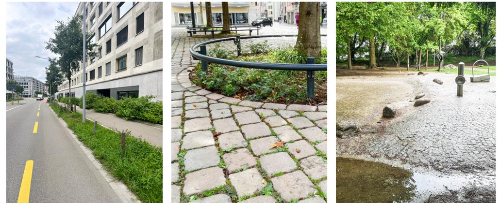
Abb.2: Grünstreifen zur Einleitung von Strassen- und Trottoirwasser, Allmendstrasse, Zürich (links); Sickerfähige Oberflächen und Baumstandort, St. Johann, Schaffhausen (mitte); Temporärer Wasserrückhalt auf Wasserspielplatz, Bucheggplatz, Zürich (rechts).
