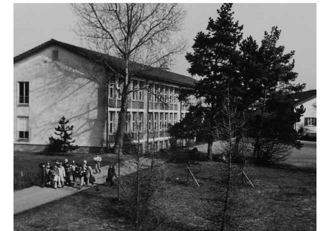
Schulhaus ohne Erweiterungen _ 1955
