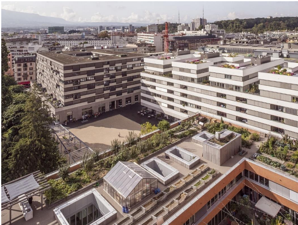
Abbildung 36: Die Dachgärten können von den Wohnungen aus eingesehen werden und bieten daher auch einen ästhetischen Mehrwert © Dreier Frenzel Architecture + Communication
