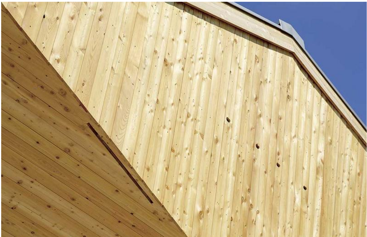
Abbildung 17: Durch die Löcher und Schlitze in der Holzfassade gelangen Mauersegler resp. Fledermäuse in die Nisthilfen © holzbau-schweiz
