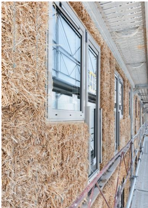
Abbildung 28: Die Nachhaltigkeit steht auch beim Gebäude selbst im Vordergrund: die Fassadenisolation besteht aus Strohballen und Lehm © Annik Wetter, Julien Germaud
