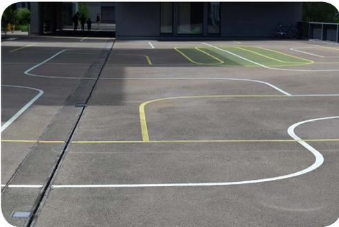
Asphalt oder Ortbeton sind grossflächige Beläge ohne Fugen. Asphalt sind Mischungen aus mineralischen Bestandteilen und bitumösen Bindemitteln, während Ortbeton mit Zement gebunden wird. Beläge ohne Fugen eignen sich für Wege, Plätze, Einfahrten, Gartenwege und andere stark frequentierte Orte. Je nach Aufbau und Dicke der Tragschicht ist der Belag befahrbar oder nicht befahrbar.
